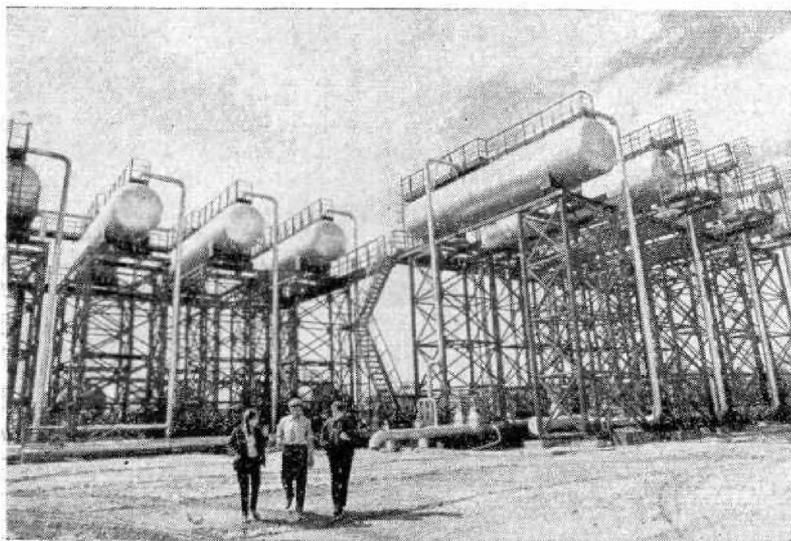
Каждый день добывают промыслы на Самотлорском месторождении десятки тысяч тонн нефти. Работает мощная термомеханическая установка по обезвоживанию нефти.
